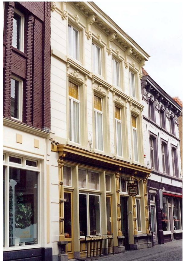
Afb. 12. Voorgevel na restauratie
