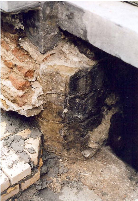
Afb. 8. Negge van de kelderingang
