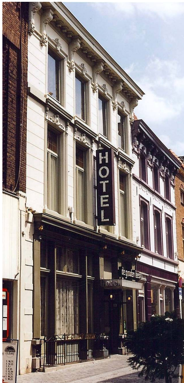
Afb. 1. Voorgevel voor restauratie
