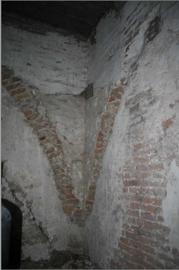
afb. 5 gewelfaanzetten in het v.m. torenportaal
