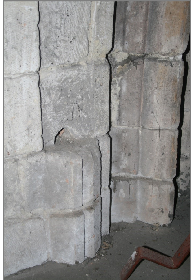
afb. 7 detail van het westvenster boven de toreningang
