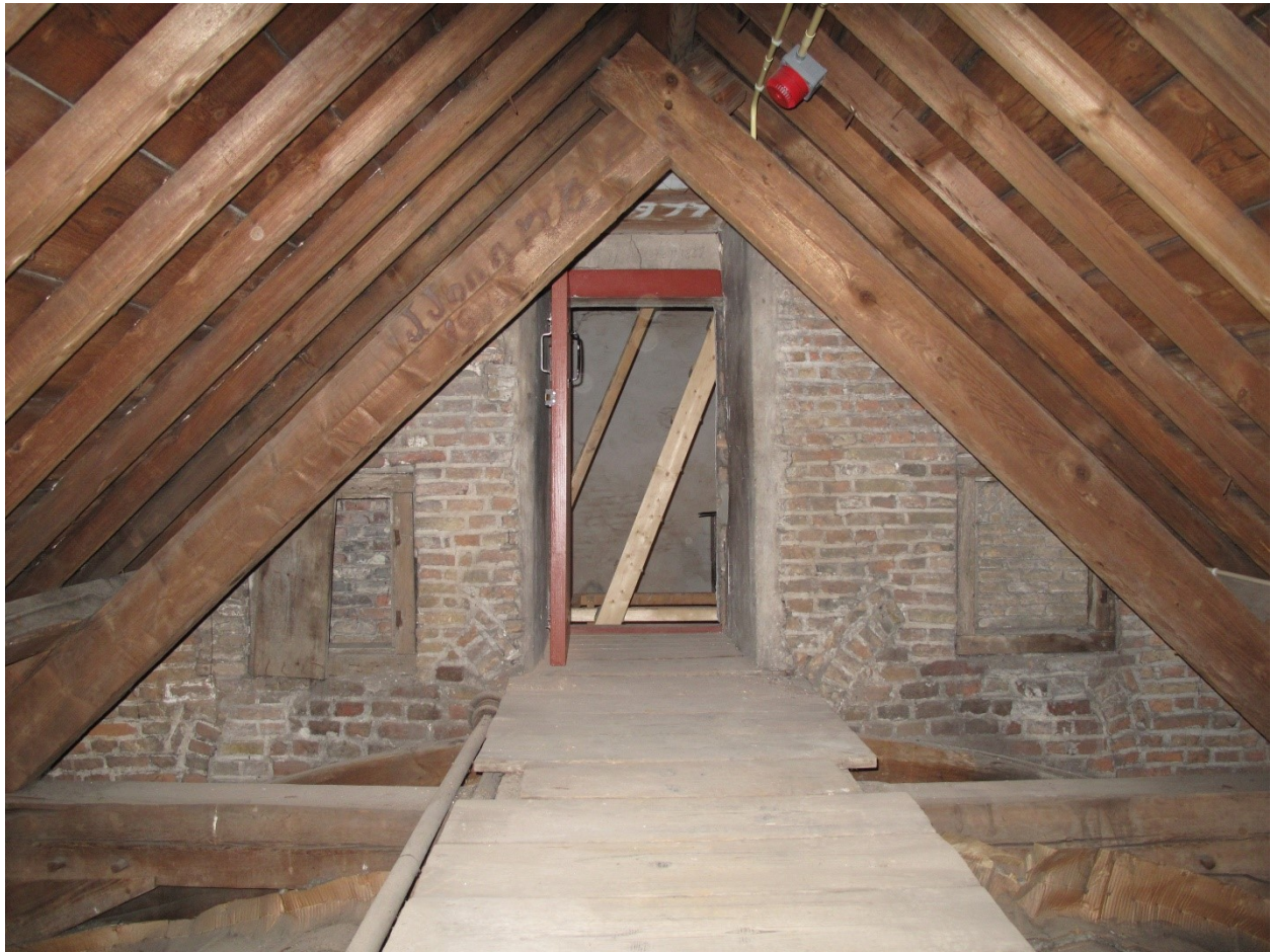
afb. 11 aftekening van galmgaten en venstertjes in de oostgevel
