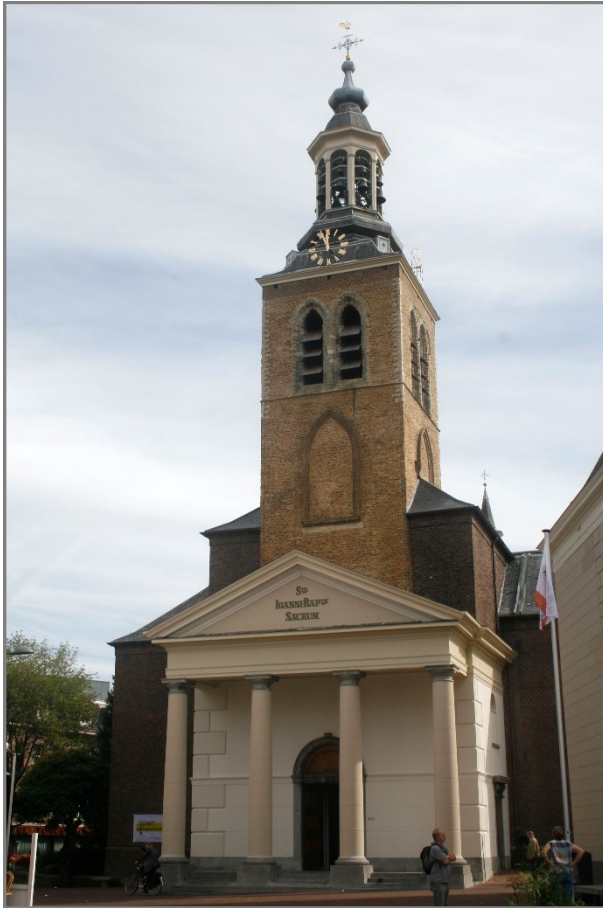
afb.10 de westgevel na restauratie in 2012
