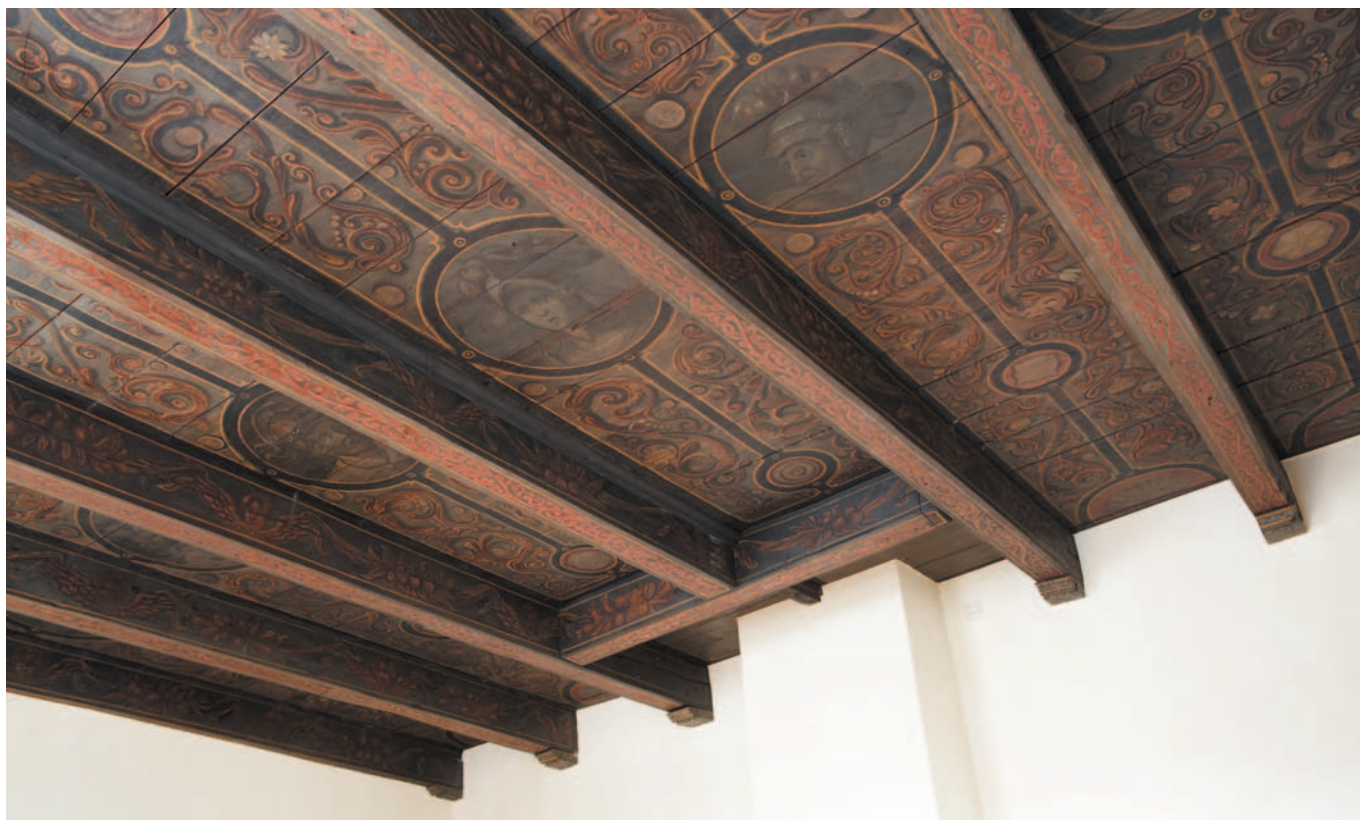
Afb. 125. Lievevrouwestraat 56, overzicht van de beschilderde balkenzoldering in 2006
