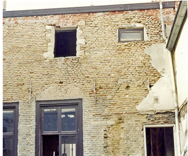
afb. 5 achtergevel na ontmanteling
