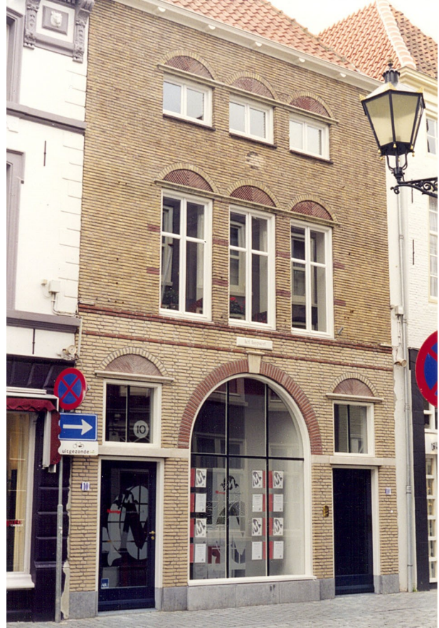
afb. 10 voorgevel na restauratie
