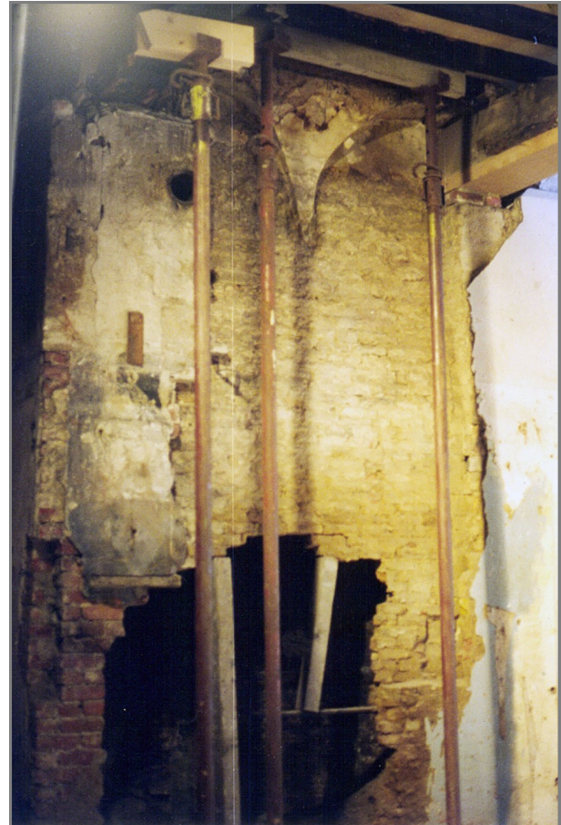
afb. 4 Sshouw parterre bij de ontmanteling
